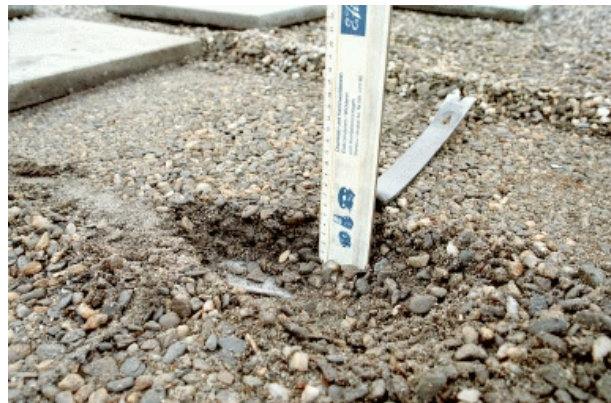
Bild 5.2: Kiesschicht unter Gehwegplatten über der Probe Nr.1
