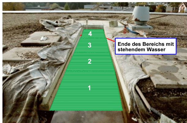
Bild 5.3: Entnahmeorte der Proben Nr.1 bis 4. nach vollständiger Probenentnahme
